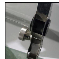
11灯管套管安装完毕
