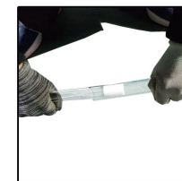
3、将灯管放入套管内
