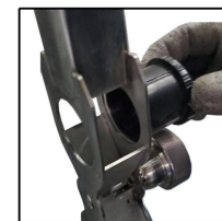
2、将套管固定座放入孔内
