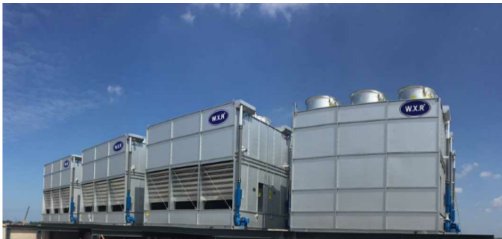
煤炭冻结工程
