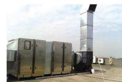
皮革厂废气光解除臭净化
