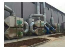
UV光解喷漆厂废气工程
