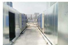
家具厂废气紫外光废气净化
